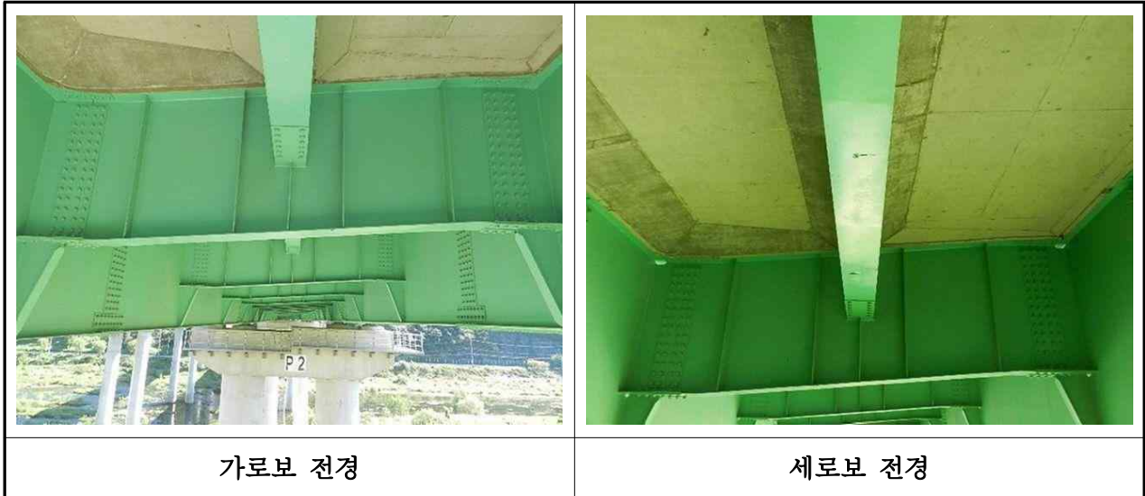
【사진 3.3.6】 가로보 및 세로보 전경(부산)
