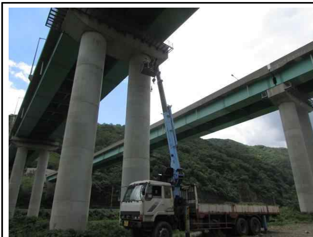
고소작업차를 이용한 조사
