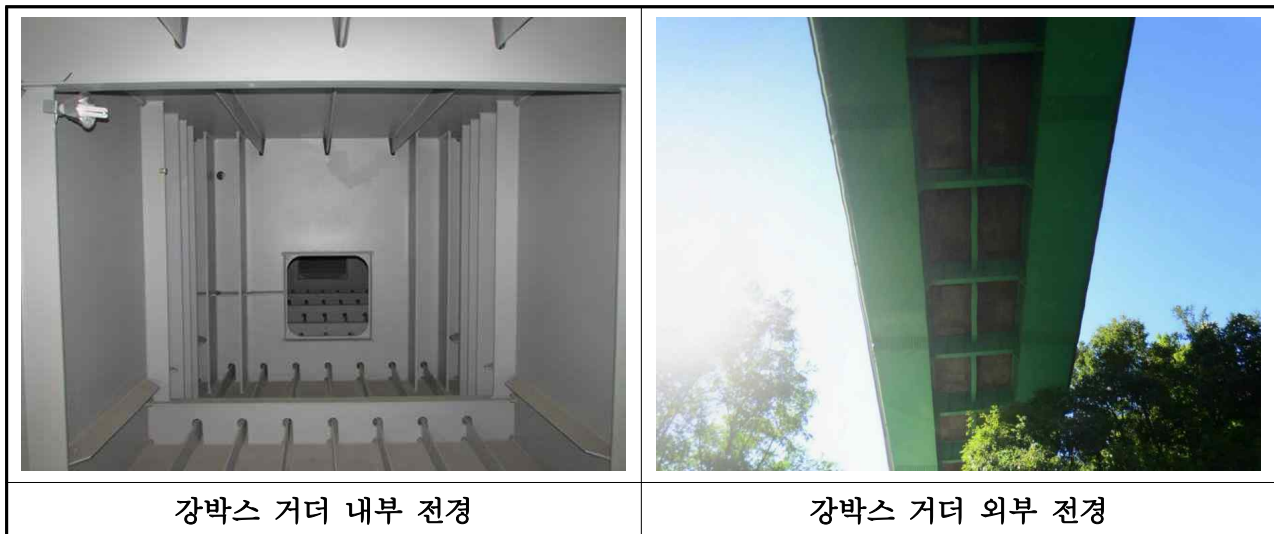
【사진 3.3.3】 강박스 거더 전경(대부산향)
