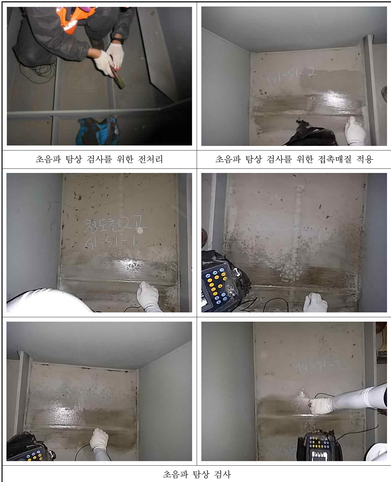
【사진 3.5.1】 강재 내구성조사 전경
