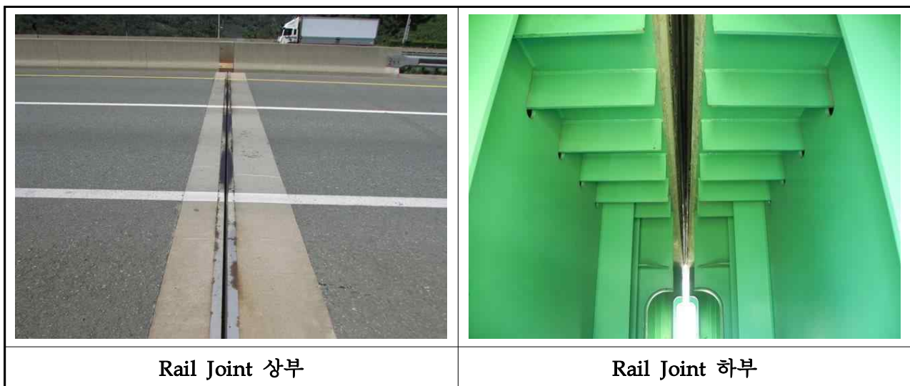
【사진 3.2.15】 신축이음장치 전경(대구)
