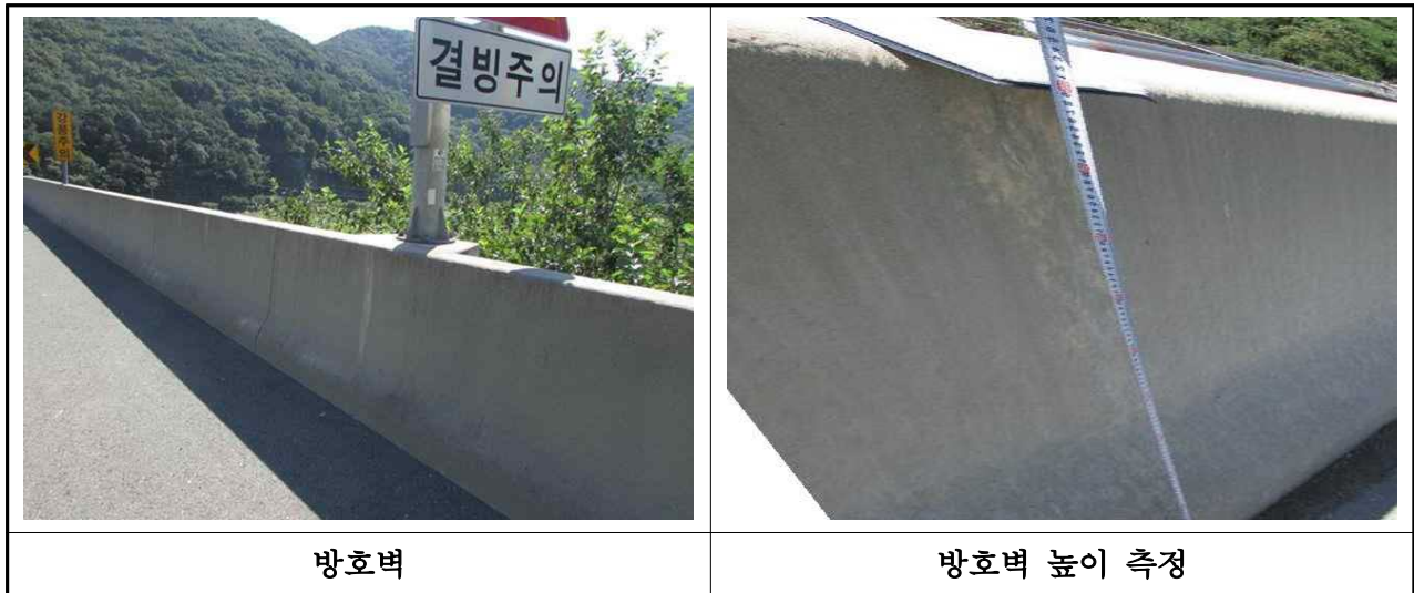
【사진 3.3.22】 난간 및 연석 전경(부산)
