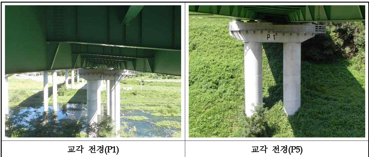
【사진 3.2.9】 교각 전경(대구)
