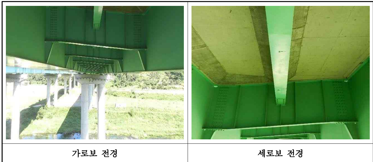
【사진 3.2.6】 가로보 및 세로보 전경(대구)
