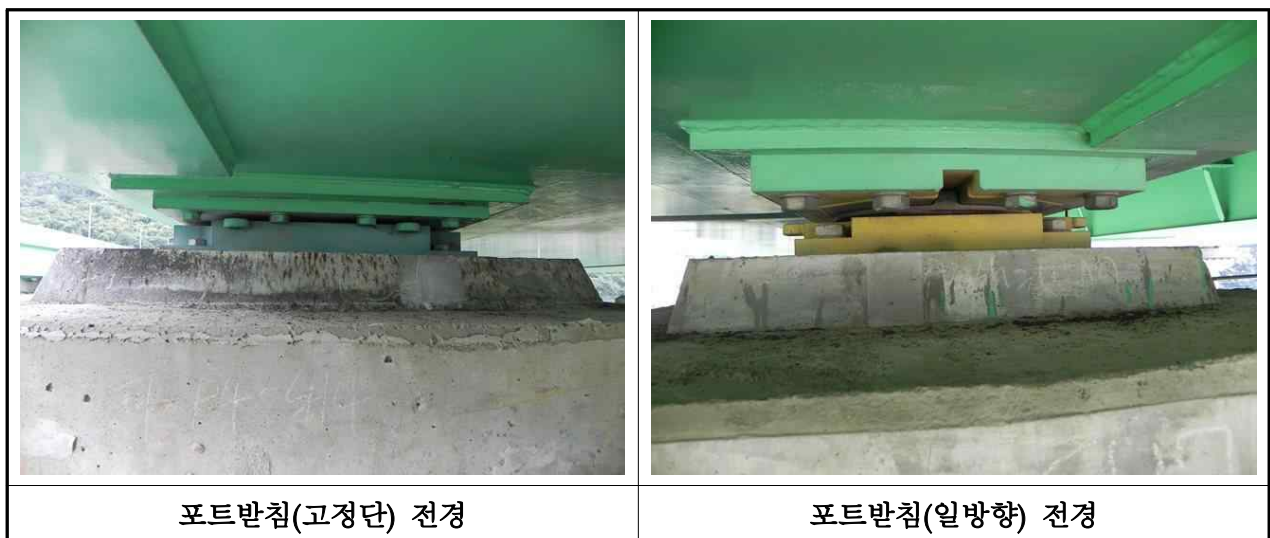
【사진 3.3.12】 교량받침 전경(부산)
