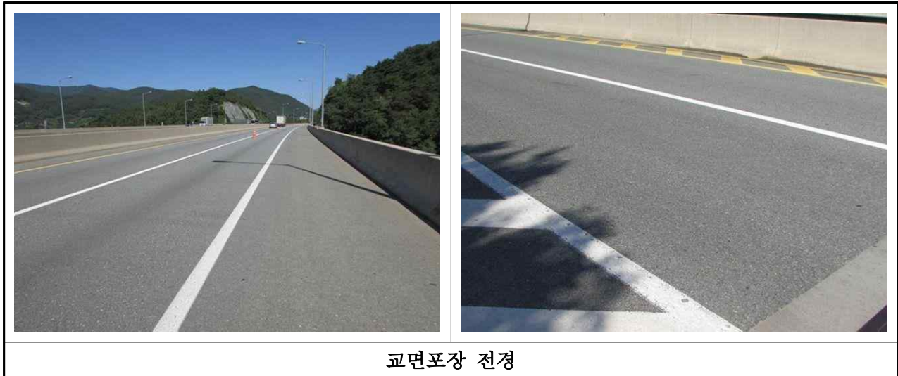
【사진 3.2.18】 교면포장 전경(대구)
