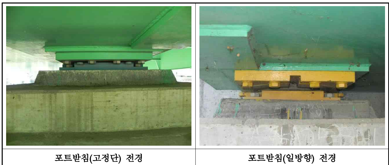
【사진 3.2.12】 교량받침 전경(대구)
