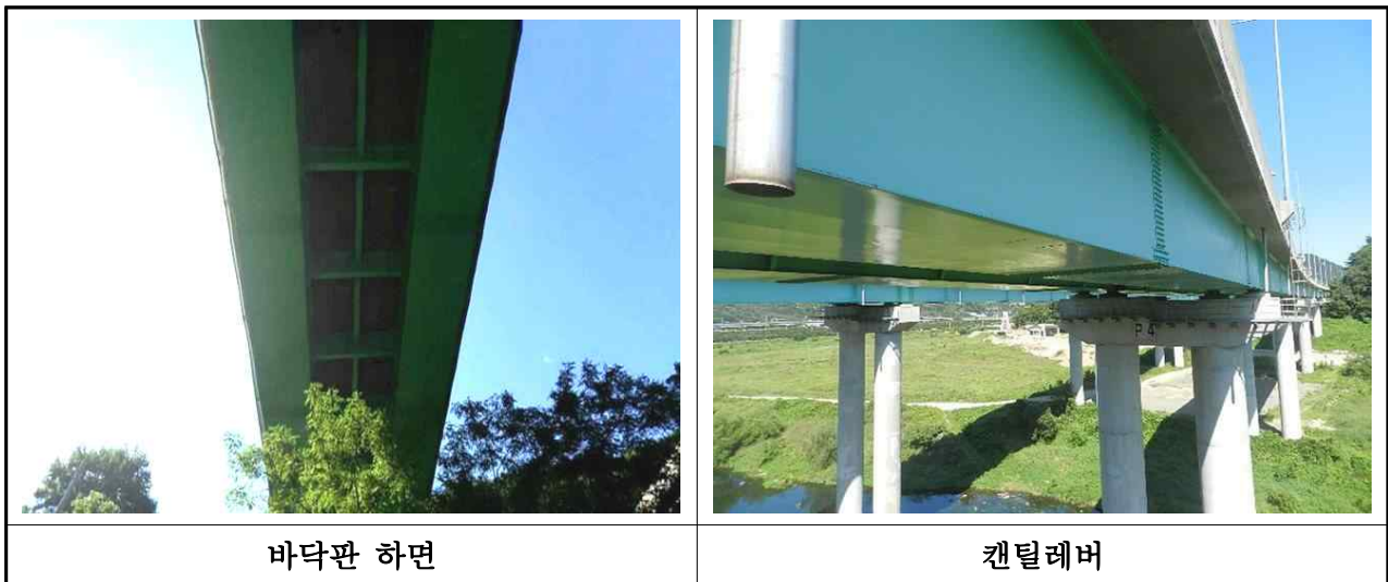
【사진 3.2.1】 바닥판 전경(대구)
