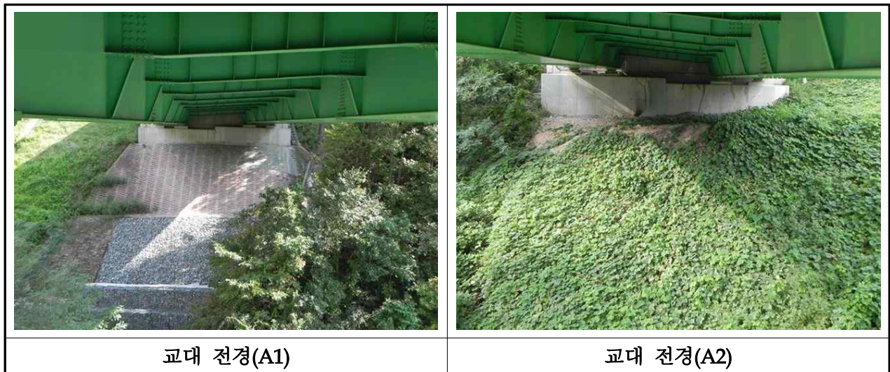
【사진 3.3.7】 교대 전경(부산)
