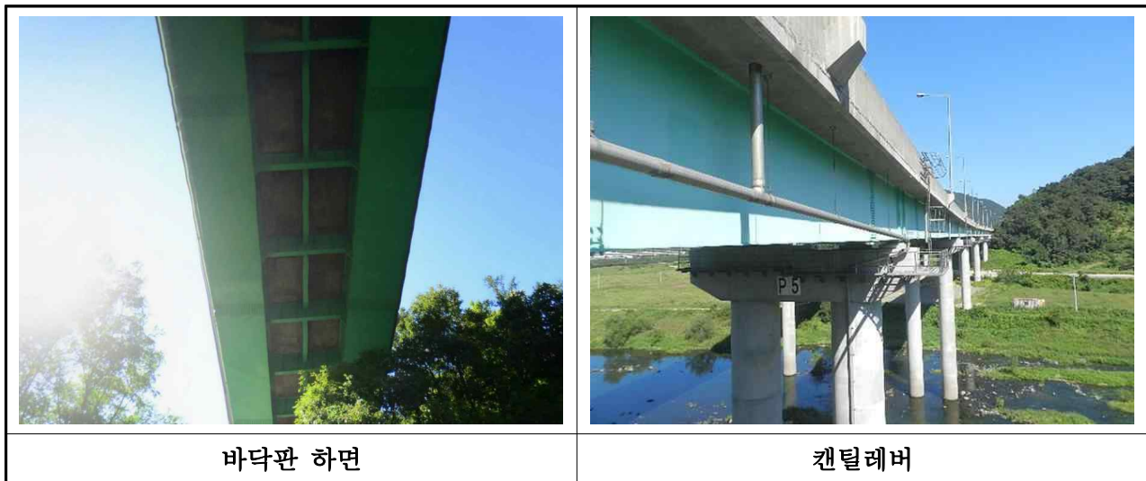
【사진 3.3.1】 바닥판 전경(부산)
