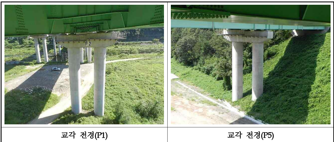
【사진 3.3.9】 교각 전경(부산)
