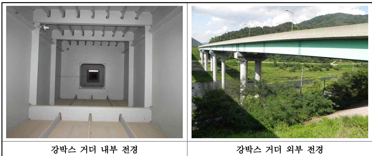
【사진 3.2.3】 강박스 거더 전경(대구)
