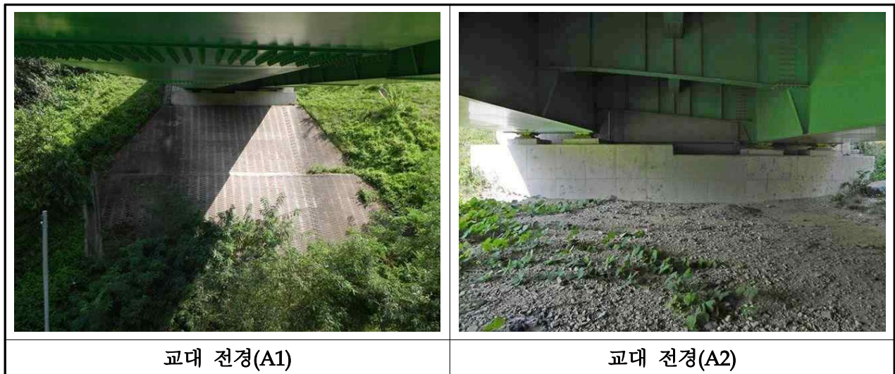
【사진 3.2.7】 교대 전경(대구)
