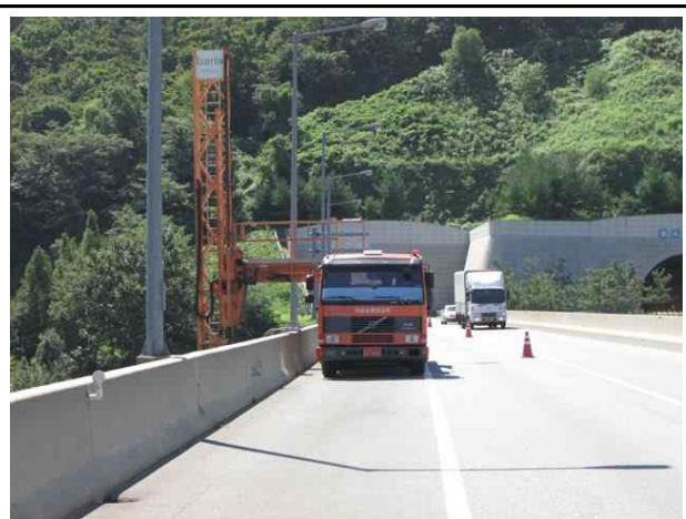
교량점검차를 이용한 조사
