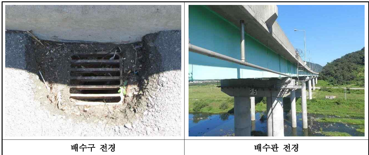
【사진 3.2.20】 배수구 및 배수관 전경(대구)
